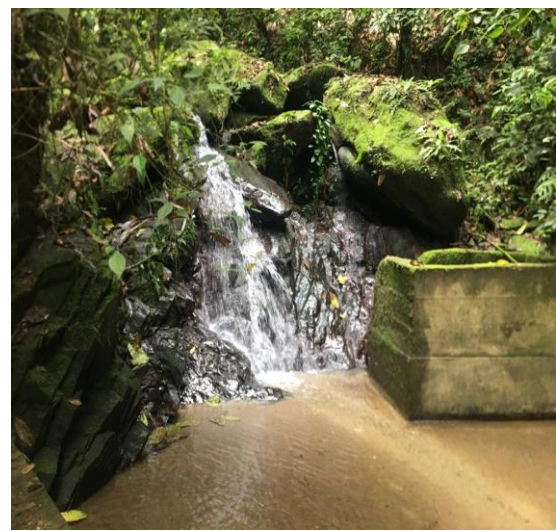
CAPTACIÓN DE AGUA POTABLE SAN VICENTE (SECTOR BELLAVISTA)
