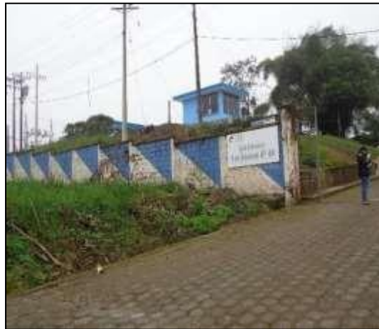
Fotografía No. 12 Subestación No 49 Los Bancos
