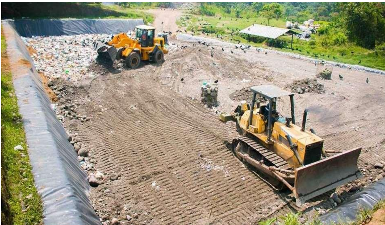
Fotografía 11. Celda emergente con recubrimiento de Geomembrana, manejo técnico y cobertura de desechos
