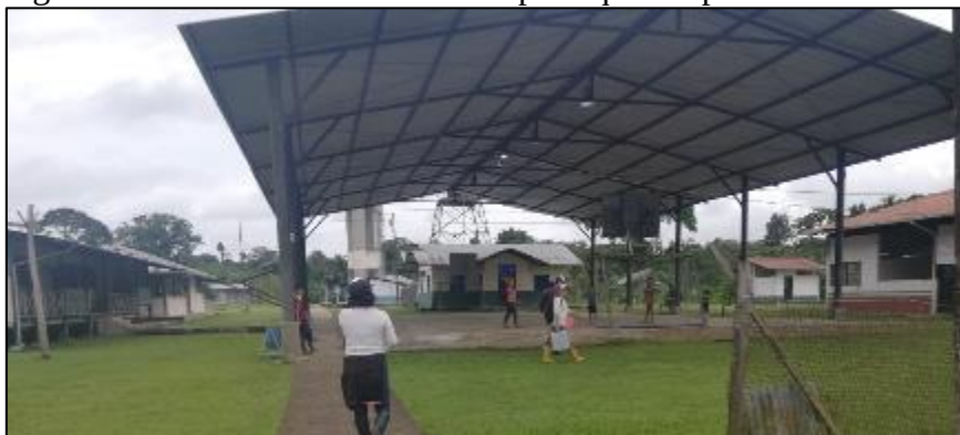
Figura N° 12. Cancha cubierta en la parroquia Cap. A. Rivadeneira.
